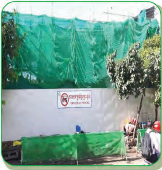
រូបភាពរបងសំងួតសី និងរបងសំណាញ់ហ៊ុមព័ទ្ធការដ្ឋាន ដើម្បីសុវត្ថិភាពសាធារណជនពេលវាយរុះរើអគារប៊ូឌីញ “ស”
