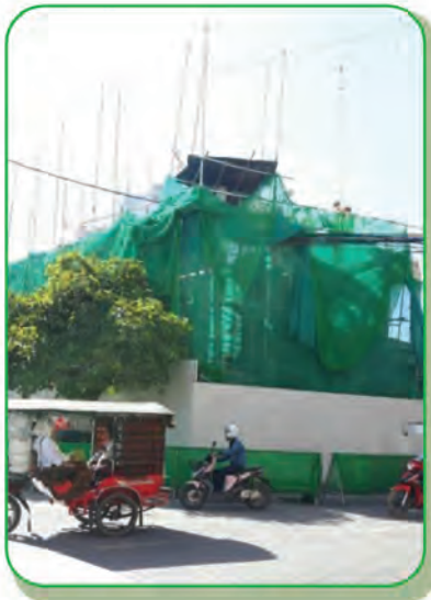
រូបភាពរបងសំងួតសី និងរបងសំណាញ់ហ៊ុមព័ទ្ធការដ្ឋាន ដើម្បីសុវត្ថិភាពសាធារណជនពេលវាយរុះរើអគារប៊ូឌីញ “ស”
