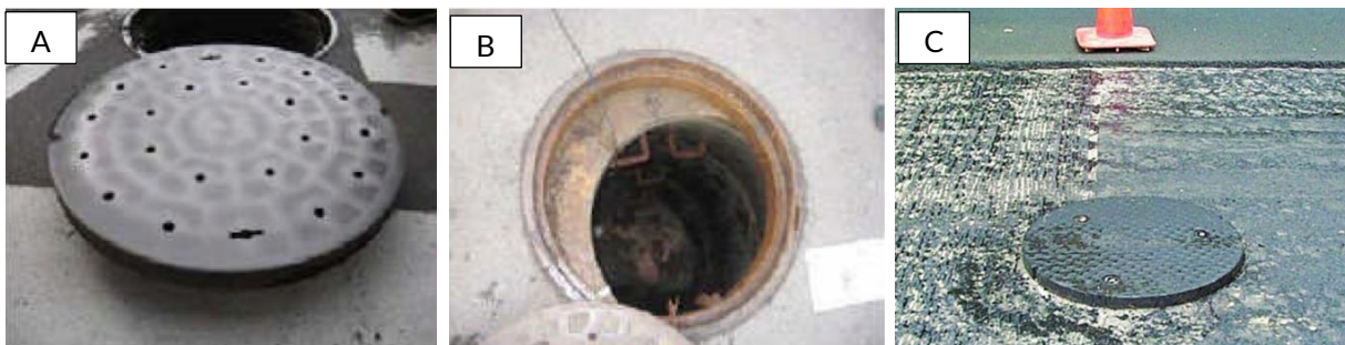
រូបភាព ២០. ឧទាហរណ៍នៃអណ្តូងលូដែលបែកបាក់ (A) គម្របអណ្តូងលូប្រហោង (B) អណ្តូងលូស្ទះ និង (C) កម្ពស់អណ្តូងលូមិនសមស្របទៅនឹងផ្លូវថ្នល់
